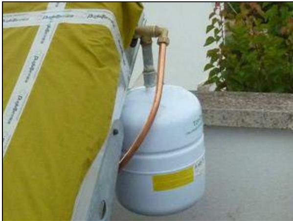
Installazione errata del vaso di espansione.
